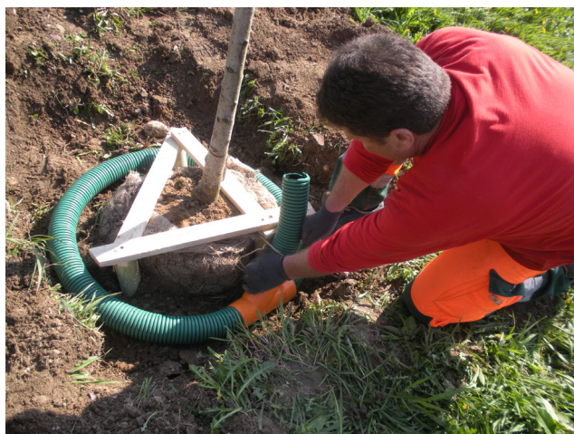
3.7 I sistemi di ancoraggio sotterranei bloccano la zolla, evitando sradicamenti in caso di venti forti
