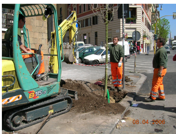
2.7 Miniescavatore impiegato per la messa a dimora di alberi
