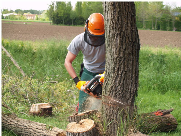
8.28 La motosega deve essere impugnata saldamente, con la mano destra sull'impugnatura posteriore e la sinistra sull'anteriore. Importante anche indossare i dpi
