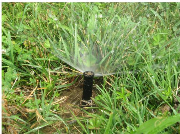
7.9 I pop-up statici possono avere numerosi bocchigli intercambiabili con modalità di bagnatura diversa: nella foto un modello con testina a 180°
