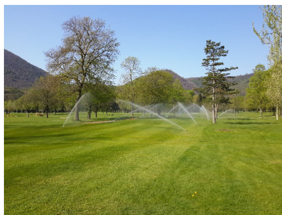
7.10 Pop-up dinamici a turbina interna mentre irrigano un tee di un campo da golf
