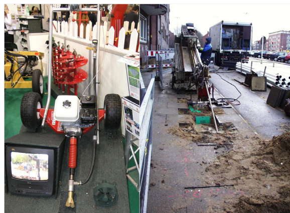
2.11 Le trivelle orizzontali sotterranee consentono la posa di tubi senza lo scavo aperto. A sinistra, un piccolo modello adatto a giardini per il superamento di piccoli ostacoli (es. pavimentazioni); a destra, posa di reti telefoniche in città (Amburgo, Germania)
