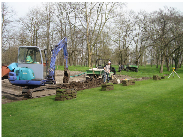
2.9 Installazione di un dreno intorno al green di un campo da golf: dopo aver tolto le zolle di prato si effettua lo scavo con un veicolo compatto movimento terra
