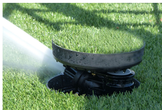
7.12 I pop-up dinamici a pistone sono irrigatori a lunga gittata indicati per l'installazione in campi sportivi ai bordi del campo
