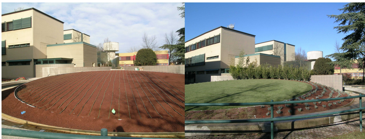
7.21 La microirrigazione interrata si presta a irrigare zone a prato di dimensioni limitate e nei casi in cui non sia consentito debordare, come nelle aiuole spartitraffico e rotatorie: predisposizione dell'impianto e lavoro finito
