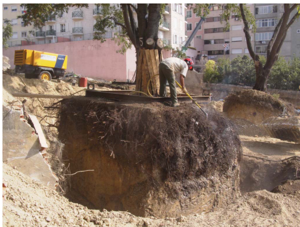
3.11 Scavo della zolla prima del reimpianto tramite lancia ad aria compressa
